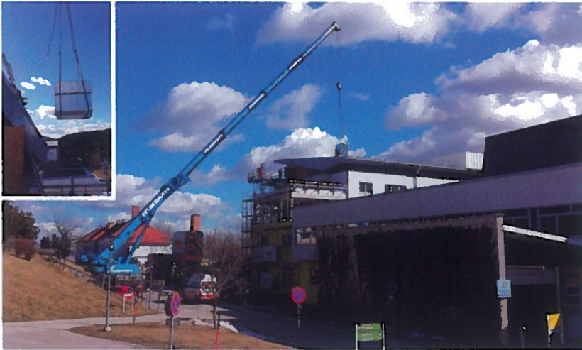
Einbringung bzw. Installation der neuen Lüftungsanlage mit WRG-Controller Eiger im Dachgeschoß.
