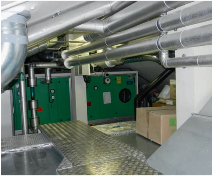
Lüftungszentrale mit WRG-Anlage – modernste Technik auf kleinstem Raum. Bilder: Konvekta
